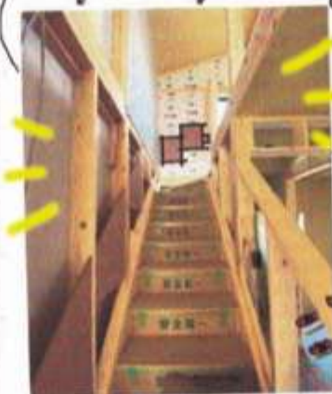
山都町 古民家リノベーション お引渡ししました。
